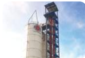
6 Terminal Sepanjang Sidoarjo, Jawa Timur Sepanjang Terminal Sidoarjo, East Java
